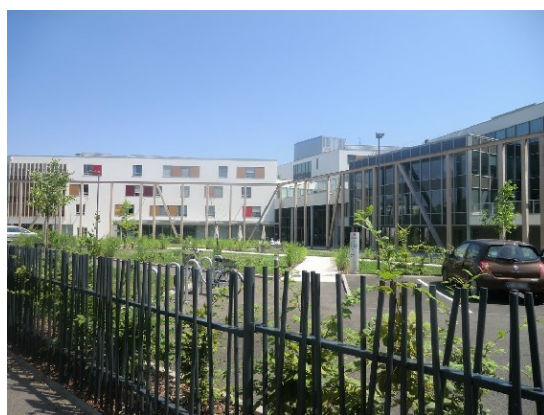
Rénovation au quartier Neuhof à Strasbourg
